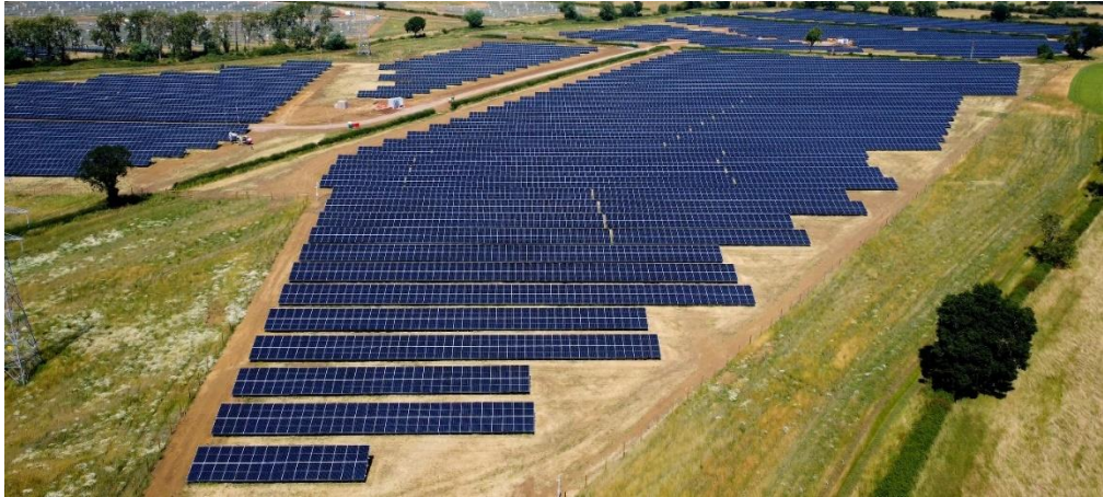
Ferme solaire Adstock – Royaume-Uni
